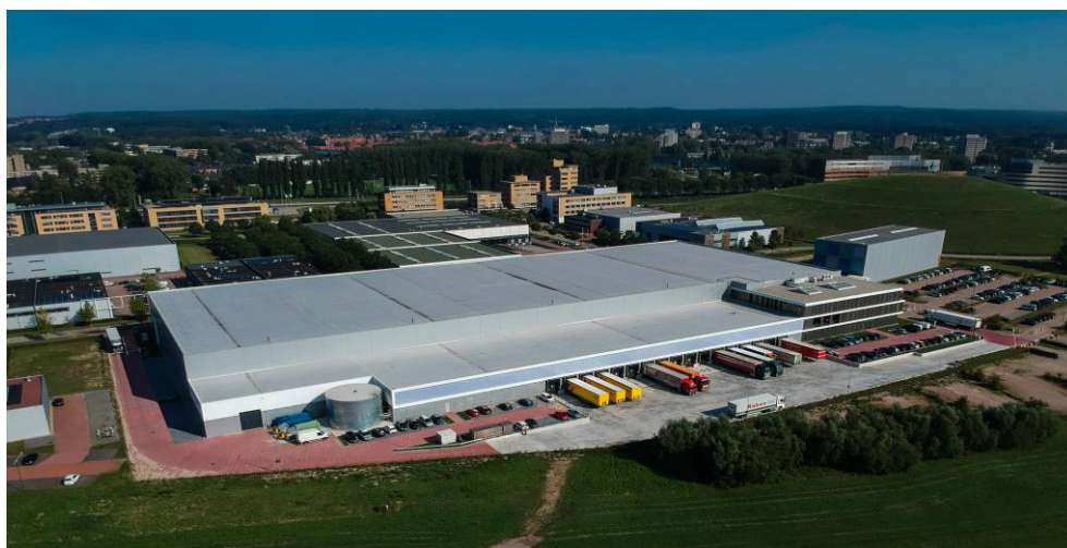
Nieuw warehouse Bunzl
